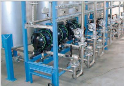
Bombas de membrana de 1 1/2" en aluminio, instaladas en la alimentación de un reactor químico.
