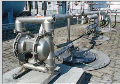
Bomba de diafragma de 1 1/2" instalada en un proceso químico para trasvasar cloruro de metileno.
