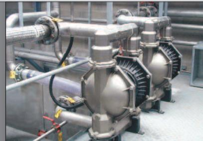
Bombas de membrana de 3" en inoxidable instaladas en un proceso de transferencia.
